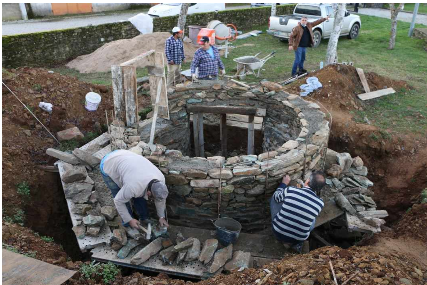
Fig. 8 – Construção do Forno Medieval de Salsas.
