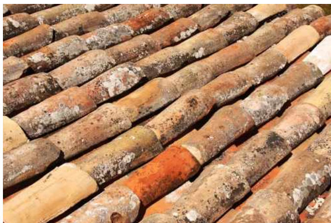
Figura 1 - Telhado de “telhas canudo” realizadas manualmente a partir de molde de madeira”.
