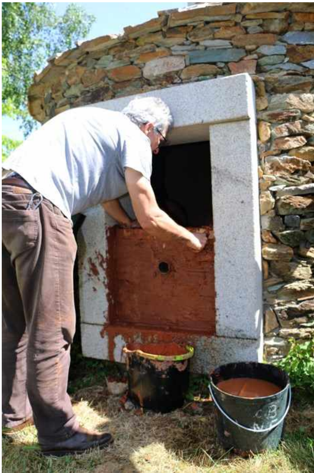
Fig. 11 – Encerramento da porta do Forno Medieval de Salsas, depois de colocadas as peças de cerâmica.
