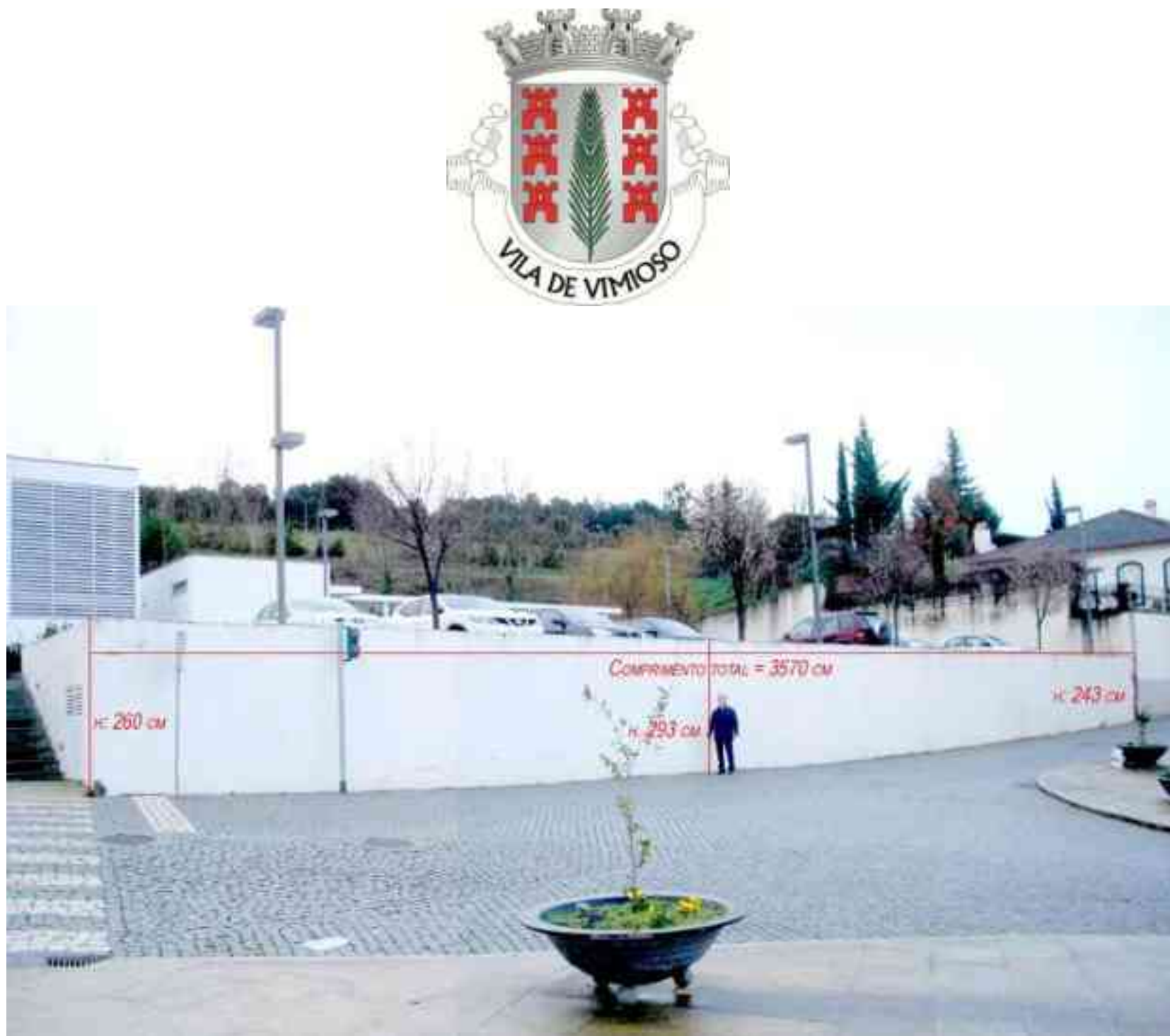
Figura 1 - Atual estado da parede que irá sofrer a intervenção.
